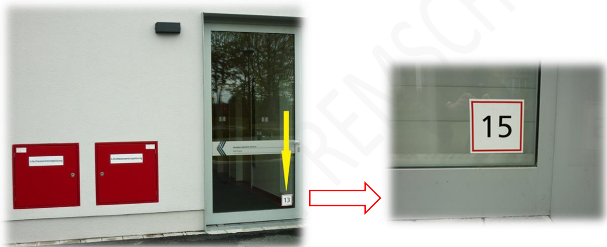
Abbildung 1: Beispiel der Kennzeichnung einer Tür
