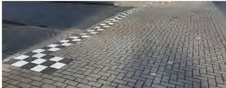
Abbildung 3-17: Unterschied Teilaufpflasterung (links) und Gehwegüberfahrt (rechts) nach EFA<sup>23</sup>
