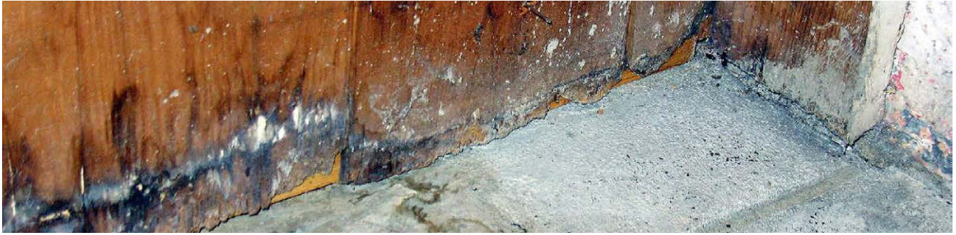
48 Schäden durch Stauwasser
