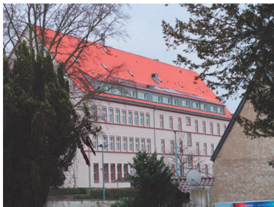
63. auf einer Schleppgaube auf der Gebäuderückseite
