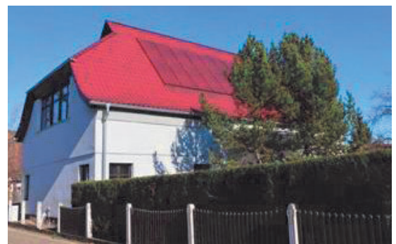
66. Farblich an die Dachfläche angepasste rote PV-Module
