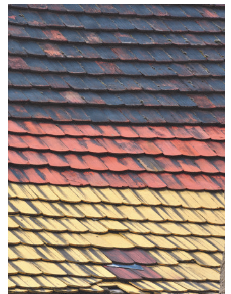
40. Biberschwanzdeckung in unterschiedlichen Farben
