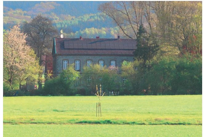
65. Farblich an die Dachfläche angelehnte dunkle PV-Module
