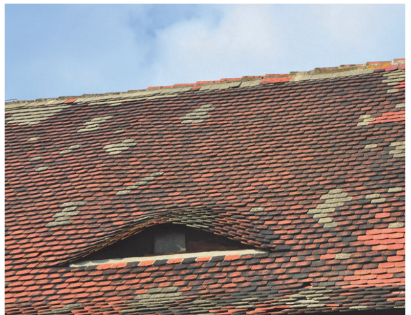
39. Biberschwanzdeckung mit eingebundener Gaube
