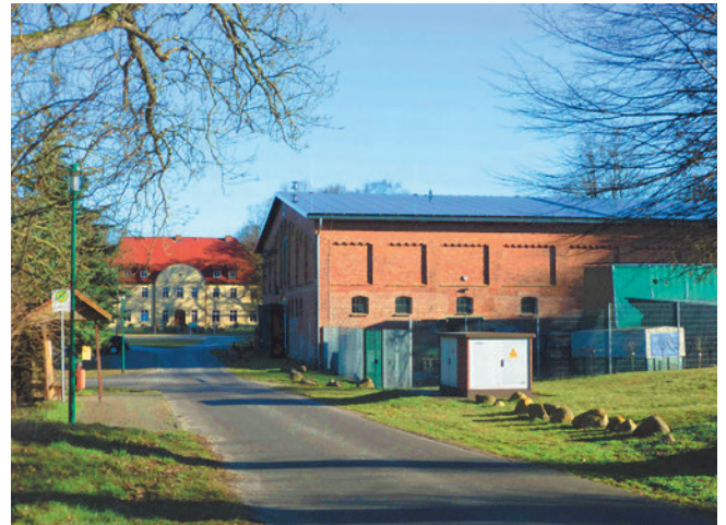
72. Vollständiger Ersatz der Dachoberfläche
