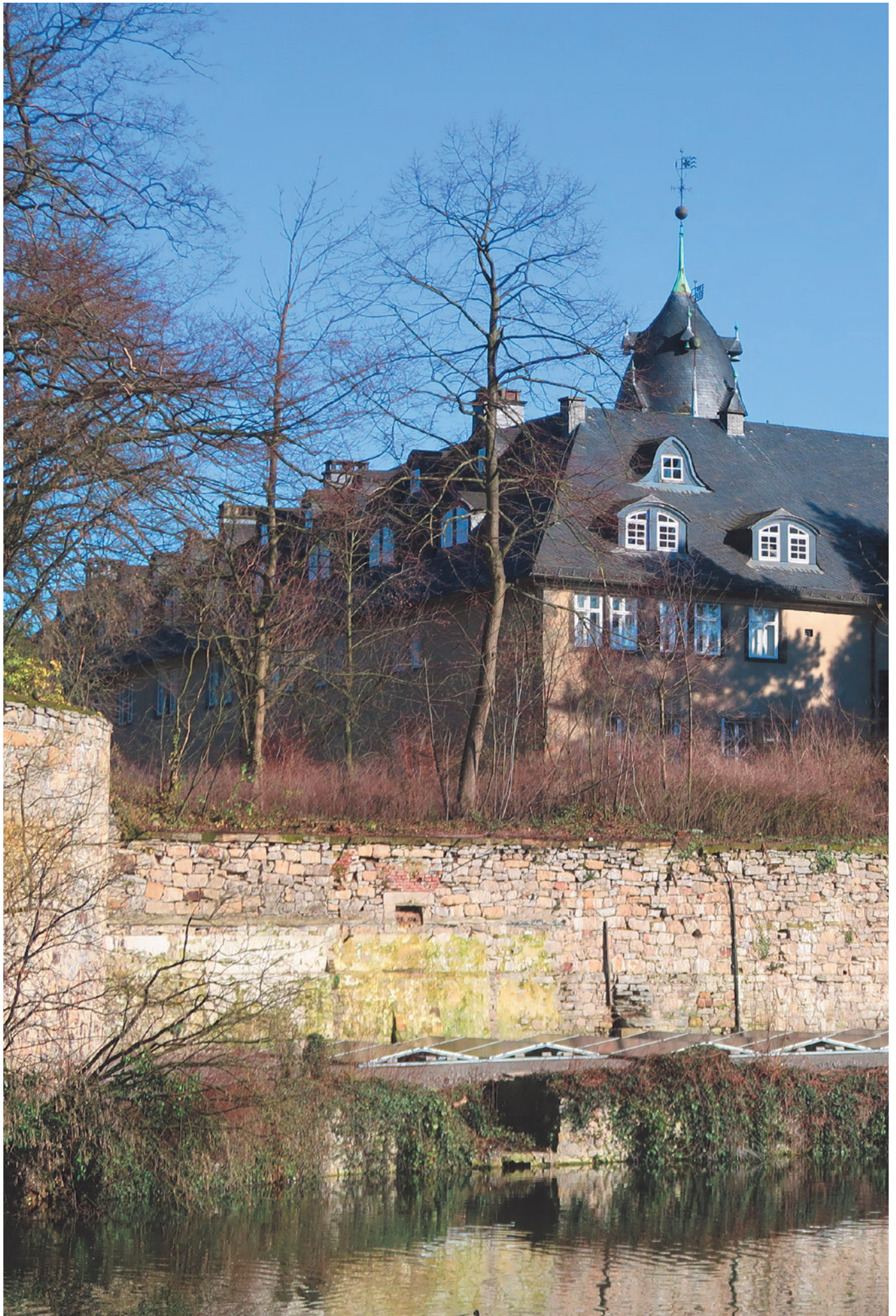
Großflächige PV-Anlage im Außenbereich einer Schlossanlage
