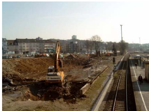
Abbildung 9-9: Freilegung des Baufeldes im März 2007
