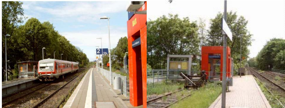
Abbildung 9-13: Bahnhof Lüttringhausen, Bahnsteig Richtung Wuppertal im ausgebauten (Ende 2006) und ursprünglichen Zustand mit DB-Pluspunkt Mitte
