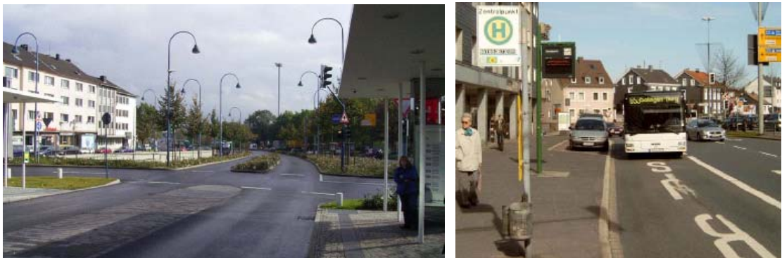
Abbildung 9-7: Busstraße Hauptbahnhof / Freiheitstrasse (l.), Bussonderspur Haltestelle Zentralpunkt in Richtung Burger Straße (r.)
