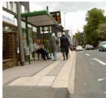
Abbildung 9-1: Barrierefrei gestaltete Haltestelle am Verknüpfungspunkt Lüttringhausen, Rathaus
