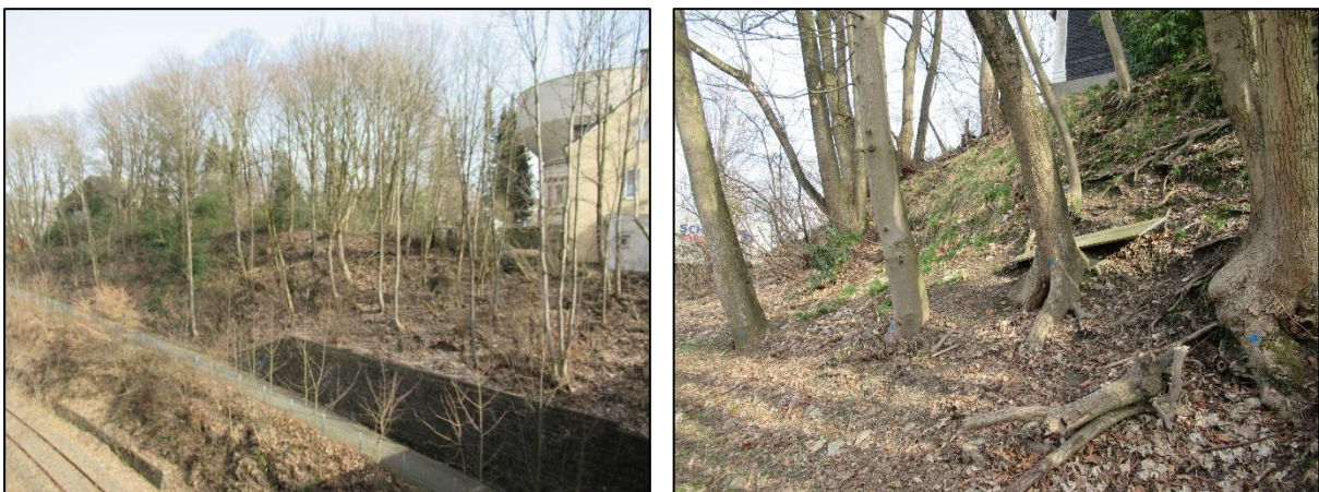
Abbildung 6: Böschungskante im Westen des Plangebietes
