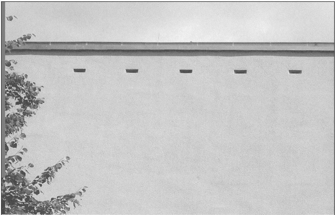
Abb. 5 – Beispiel für eingelassene Fassadenquartiere für Fledermäuse
