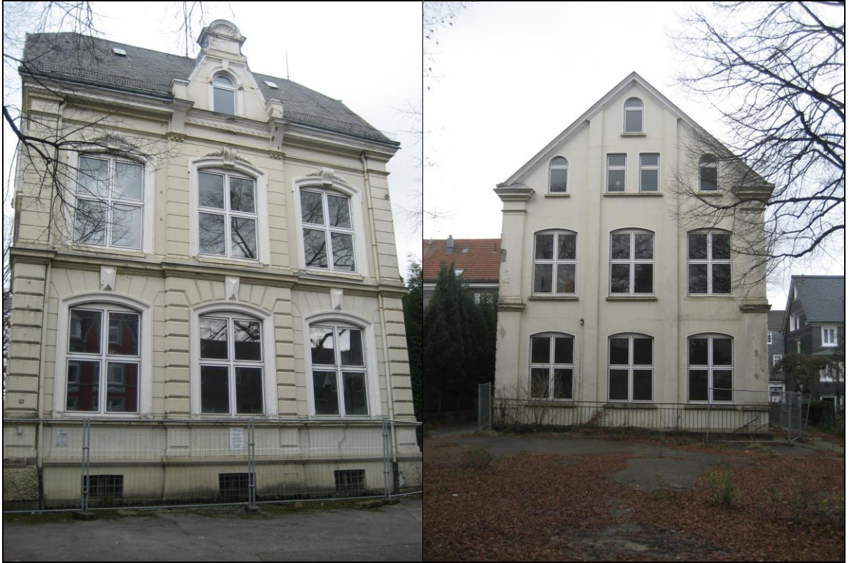
Schulgebäude Kölner Str. 94, ehem. Schule Glocke (Leerstand) – Nr. 240 der Denkmalliste
