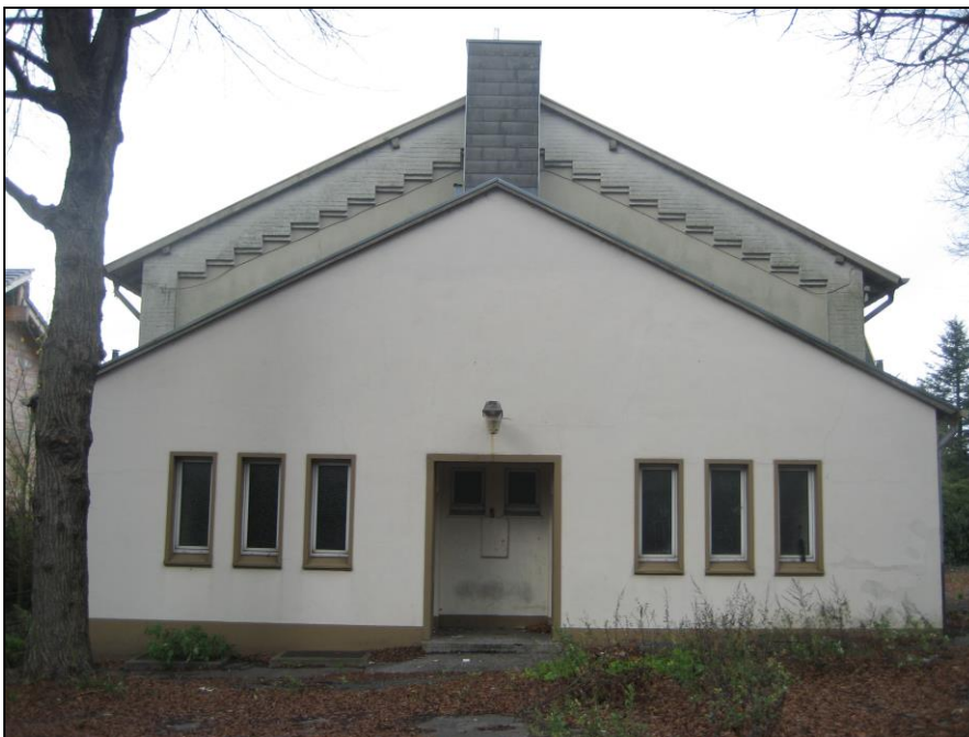
Sporthalle Kölner Str. 94, ehem. Schule Glocke (Leerstand) – Nr. 240 der Denkmalliste
