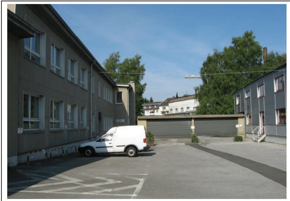
Abb. 1: Parkplatz vor dem Gebäude, RKS 1, RKS 2 und RKS 3
