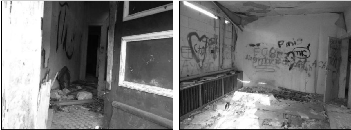
Abbildung 12: Innenbereiche des verfallenen Villengebäudes
