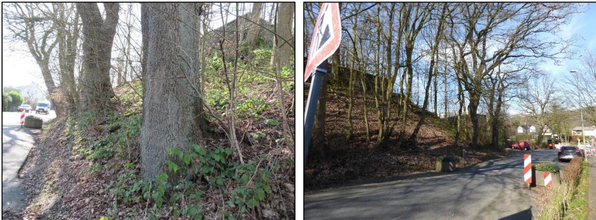
Abbildung 6: Östlicher Böschungsbereich im Bereich der Düppelstraße
