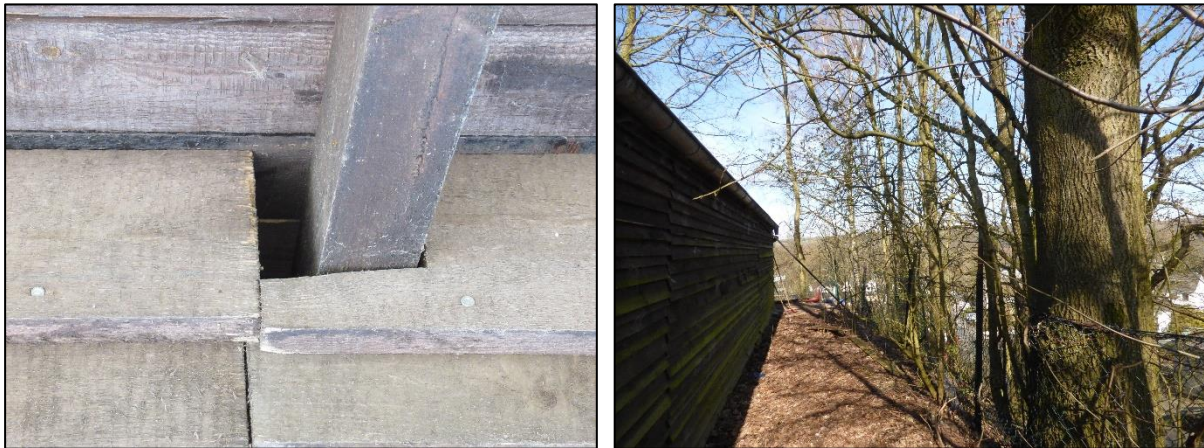
Abbildung 11: Potenzielle Einflugöffnung an der Garagenverkleidung / Rückseite der Garagen mit östlichem Gehölzbestand
