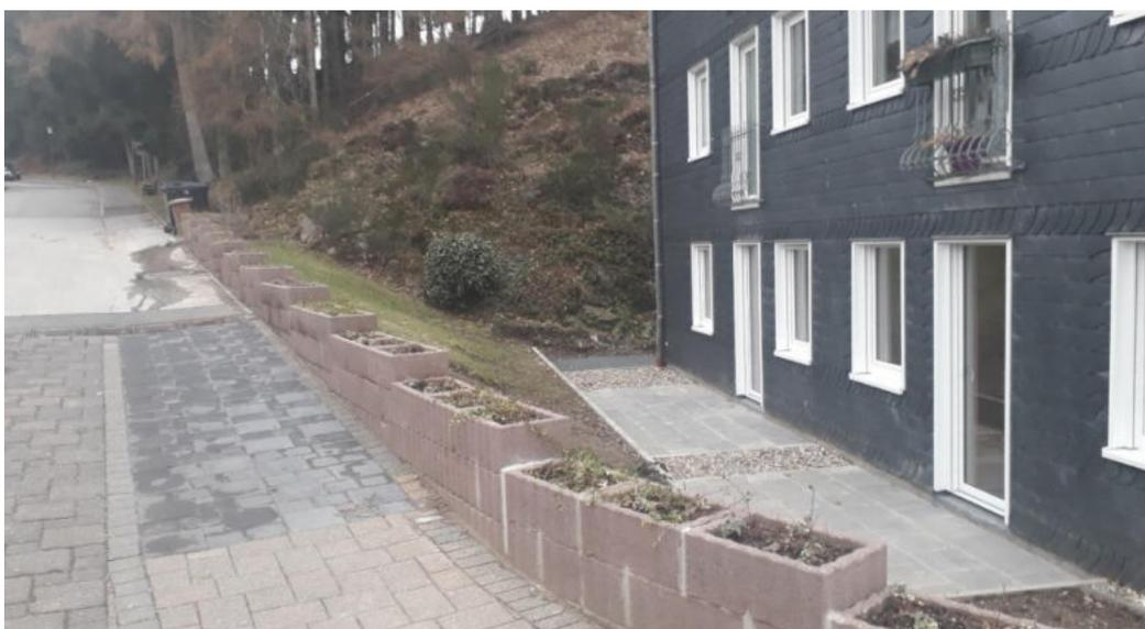
*Abb. 4-10: Ausführungsbeispiel Mauer mit Lenkungswirkung bei urbanen Sturzfluten*
